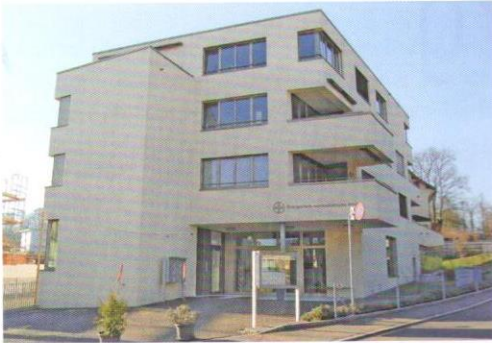
In diesem Mehrfamilienhaus befindet sich die EMK.
